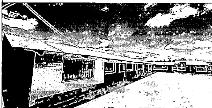
Foto 1: Area donde se realizará la instalación de estructura y reparación de techo
