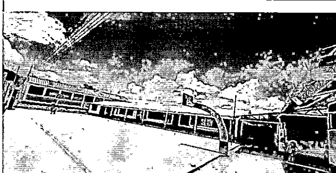
Foto 4: Area donde se realizará la instalación de estructura y reparación de techo
