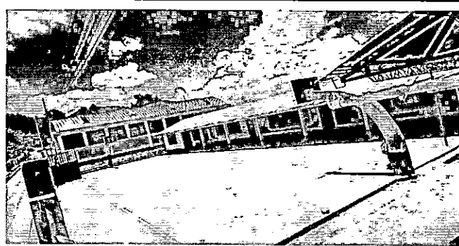
Foto 6: Area donde se realizará la instalación de estructura y reparación de techo
